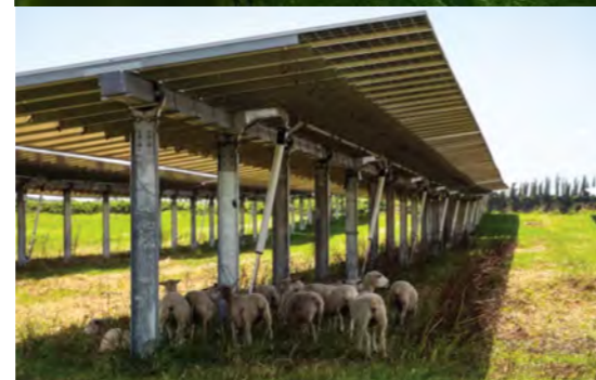
Kohirā - Kaitaia Solar Farm
